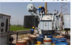
به گزارش امور طرح و توسعه، ابتدا عملیات دمونتاژ در ایستگاه ۶۳ کیلوولت اوشیب صورت گرفت و پس از بارگیری و حمل در محل کنونی در دابودشت نصب و به بهره برداری رسید. مراحل دمونتاژ، ترانس و متعلقات آن، تجهيزات اتاق فرمان و همچنين حمل و نصب كامل، تست و راه اندازی در مدت ۱۵ روز به اتمام رسید.
